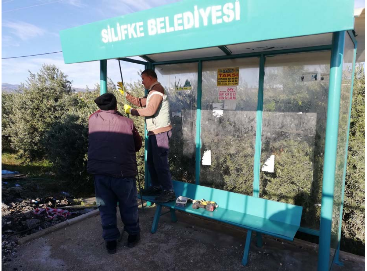
Otobüs duraklarında bakım boyama
