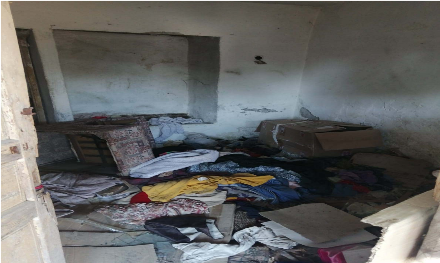
19- Vatandaşın yanan evinin temizliđi yapıldı.
