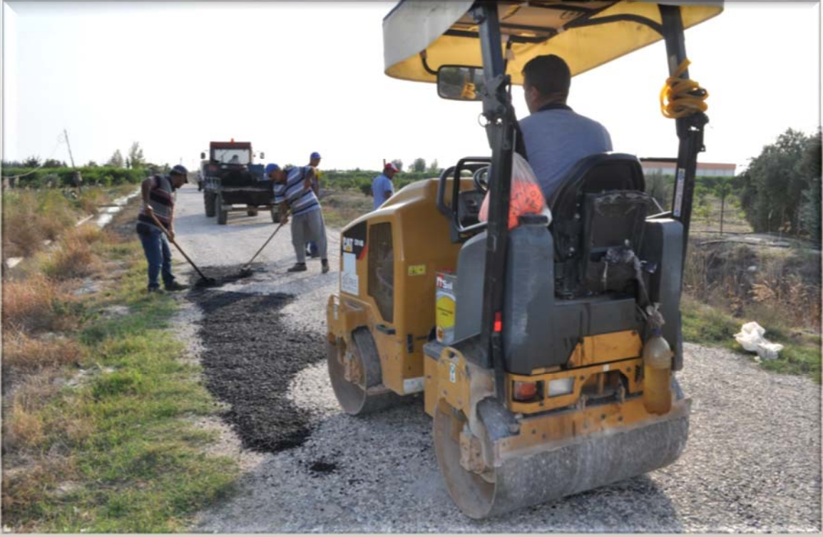
Asfalt ve Yama Çalışması
