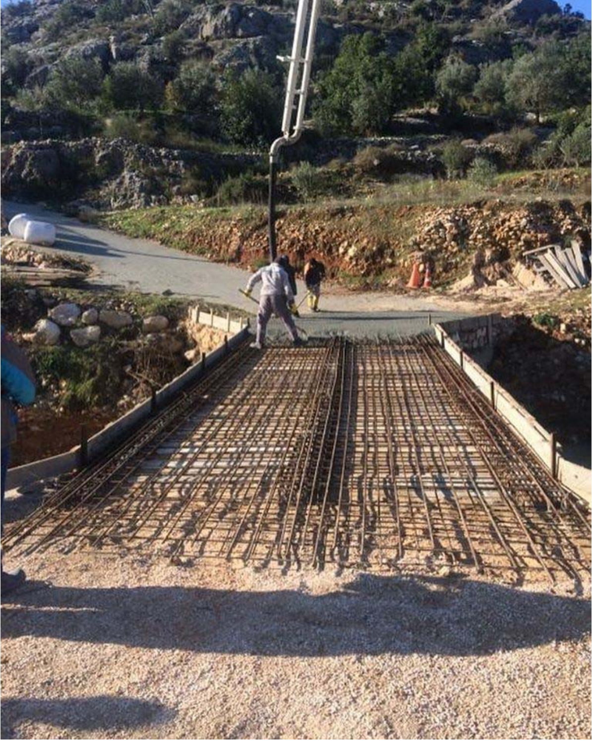
Afetden zarar gören köprü yapımı
